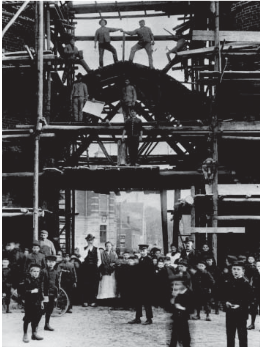
Einbau des Mittelstücks am Lüdinghauser Tor (1908). Auf dem Gerüst mit Plan der Polier Theodor Klaverkamp.
